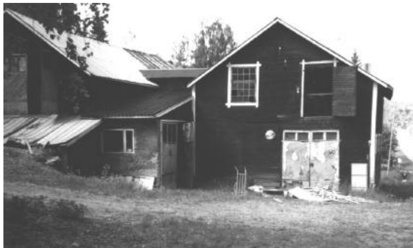
Den gamla fabriken i förfall efter nära 100 år, före rivning sommaren 2005.
